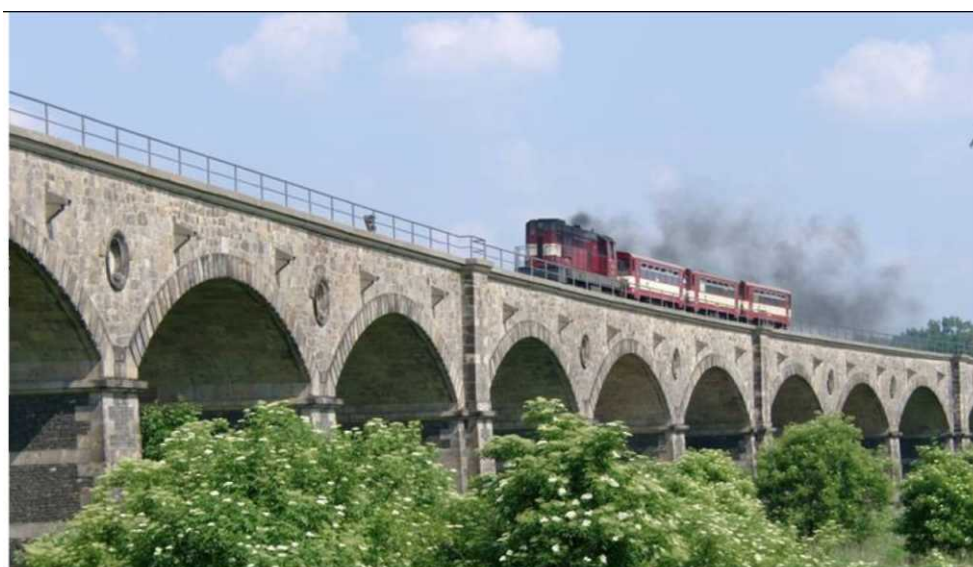
Рис. 1. Железнодорожный мост "Neisse", Германия
