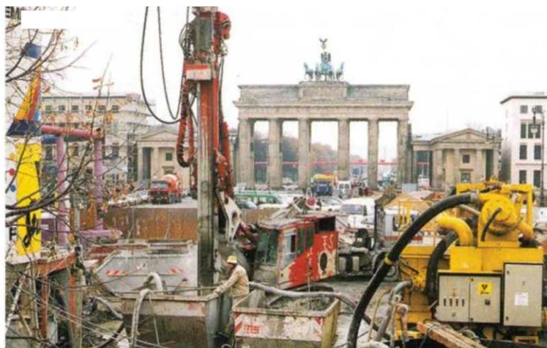
Рис. 1. Строительные работы рядом с Бранденбургскими воротами в Берлине, Германия
